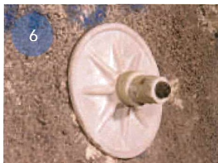
6 Endelig stramming av KGC KW-ankeret
